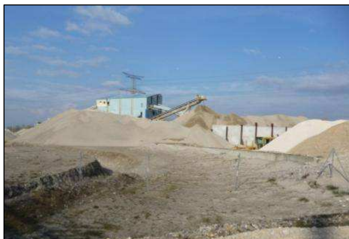
Figure 41 : Plateforme de traitement de la carrière LAFARGE
