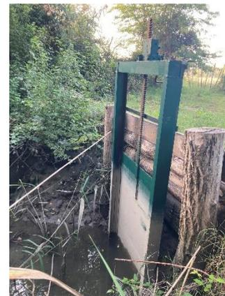
Figure 2 : Nouvelle martelière dans le cadre du CN au Mas de la Cure
